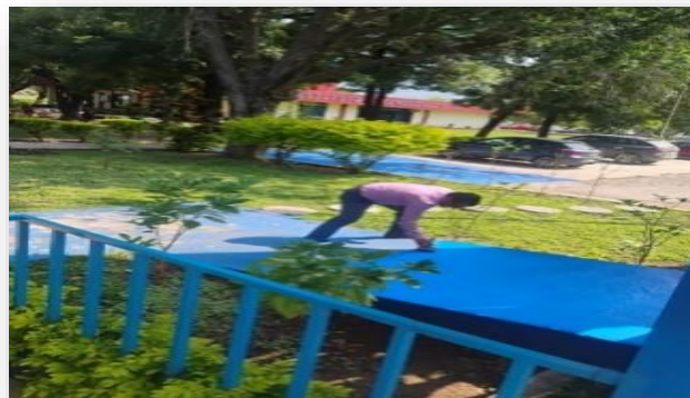
Imagen 17. Mantenimiento de pintura a rampas.
